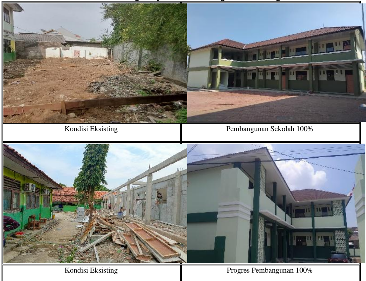
Gambar 3.4 Dokumentasi Meningkatkan Kualitas Bangunan Gedung Pemerintah
